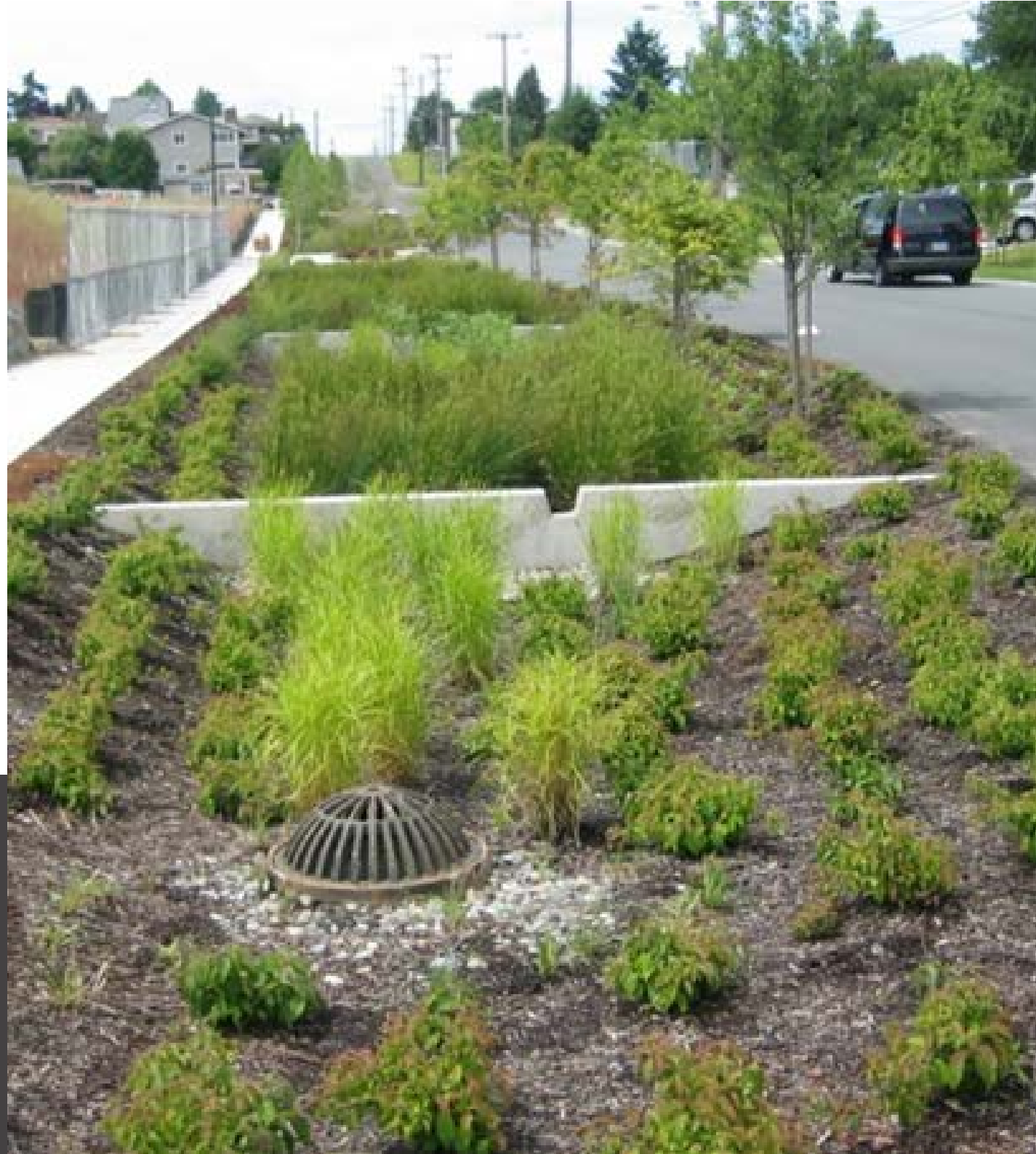
Fig. 7.4: punto di uscita dell'acqua con griglia di protezione. Fonte: www.holemanlandscape.com
