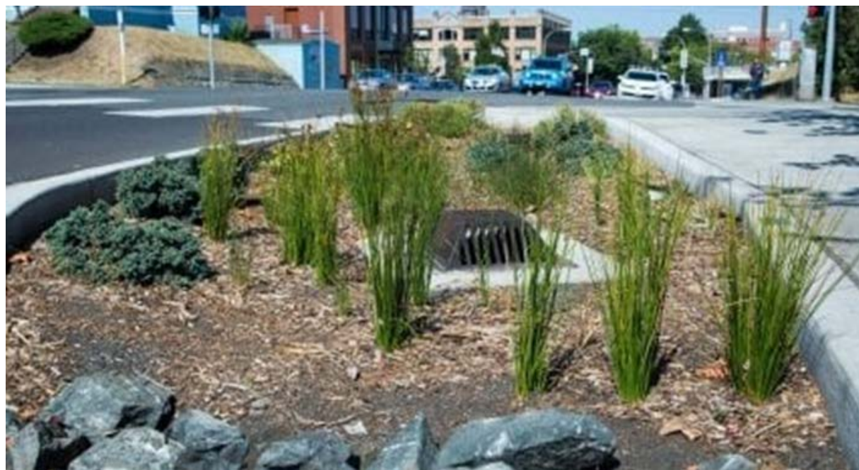
Fig. 2.12: troppopieno con griglia di protezione. Fonte: https://cob.org/
