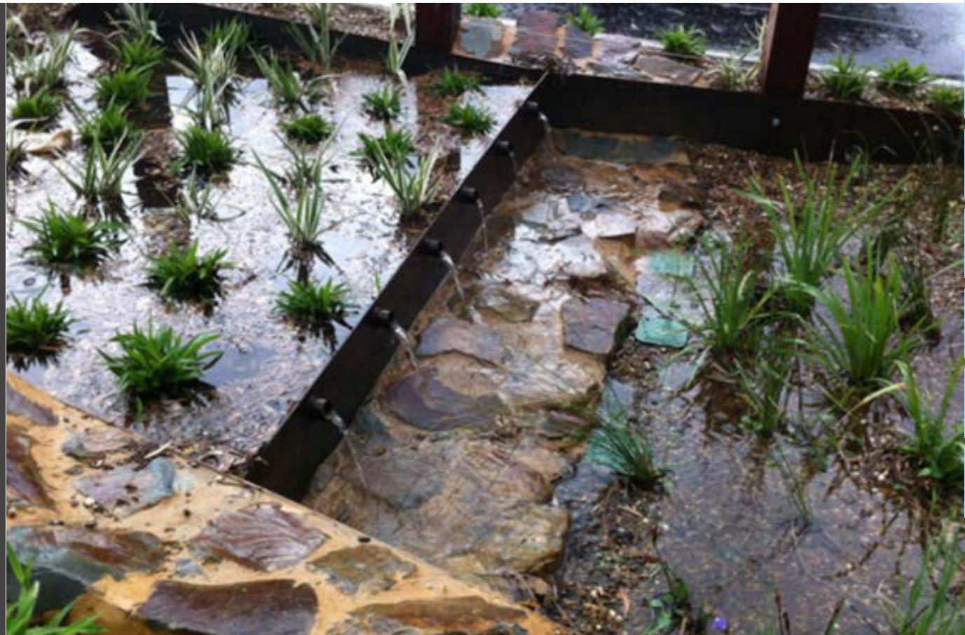
Fig. 2.5: esempio di dighe di controllo in aiuola di bioritenzione in pendenza.
