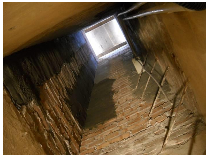
APPLICAZIONE TESSUTI ALL'INTERNO DELLA TORRE CAMPANANRIA
