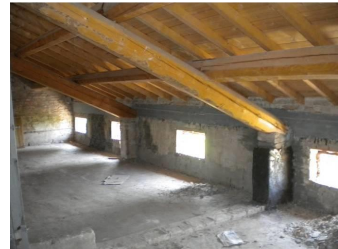
FASCIATURA INTERNA CON FIBRE DI VETRO
