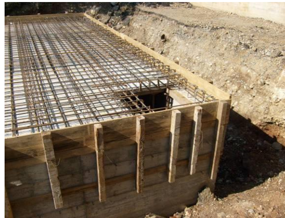
ARMATURA SOLETTA COPERTURA VASCA
