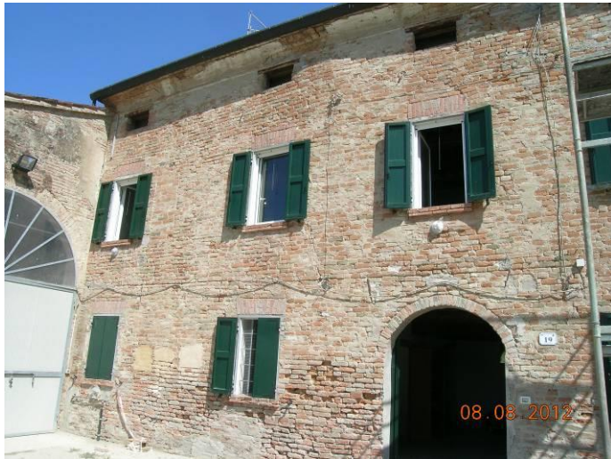
FACCIATA EDIFICIO PRIMA DELL'INTERVENTO
