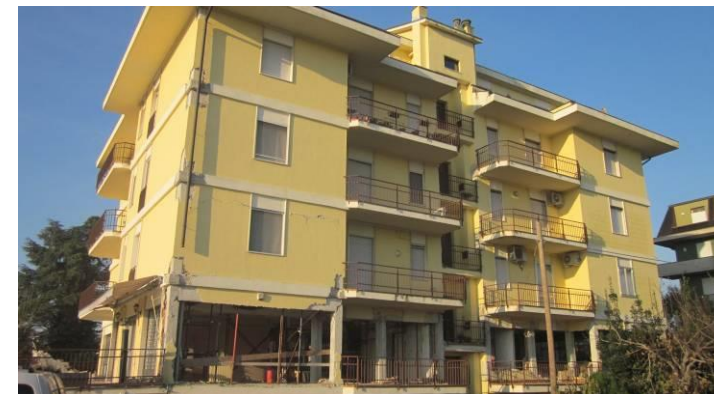
VISTA DI INSIEME DELL'EDIFICIO
