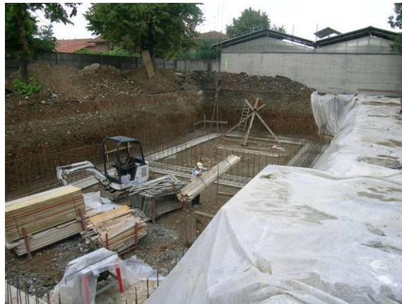
SCAVO GENERALE E ARMATURA MURI
