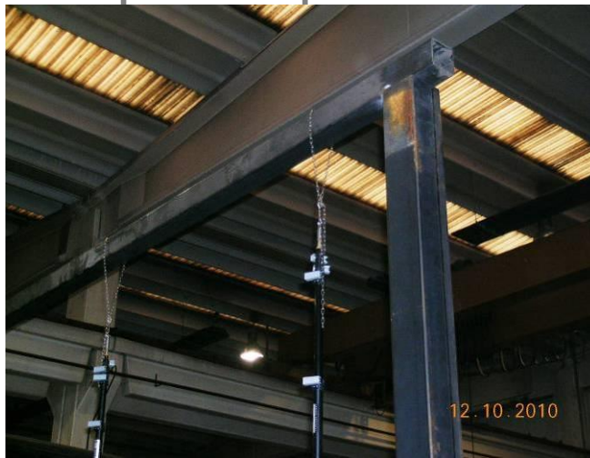
DETTAGLIO AGGANCIAMENTO ASTA ALLA STRUTTURA
