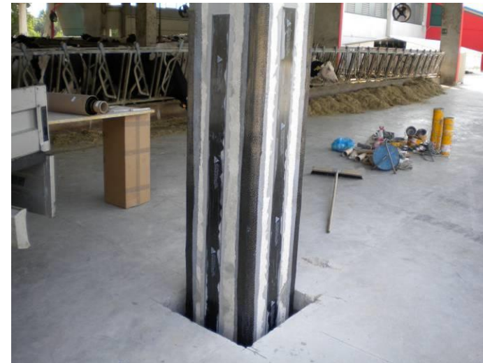
RINFORZO CON FIBRE DI CARBONIO – FASE 1
