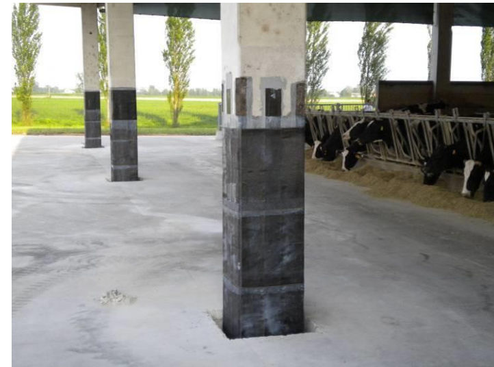
RINFORZO CON FIBRE DI CARBONIO – FASE 2
