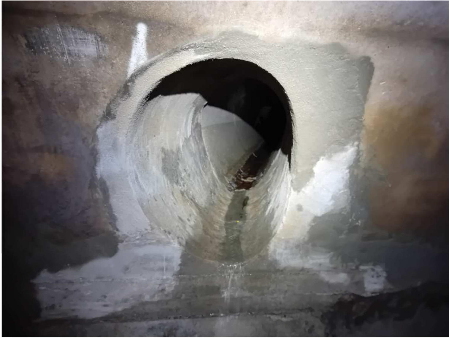
SITUAZIONE A LAVORI DI MESSA IN SICUREZZA CONCLUSI MEDIANTE RIEMPIMENTO DELLE MACRO CAVITA'
