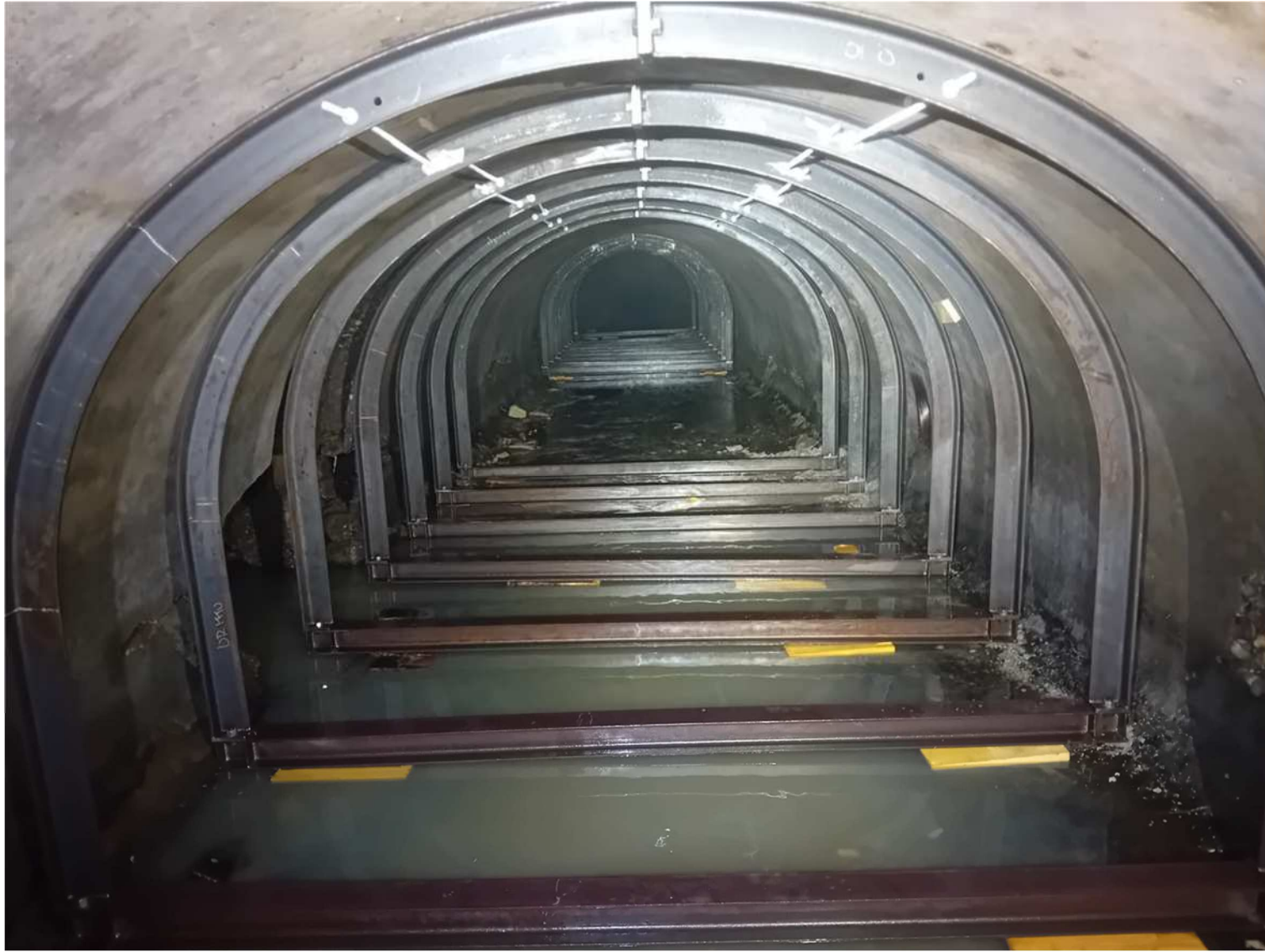
MESSA IN SICUREZZA PER L'ESECUZIONE DEI LAVORI MEDIANTE POSA DI CENTINE METALLICHE REALIZZATE SU MISURA
