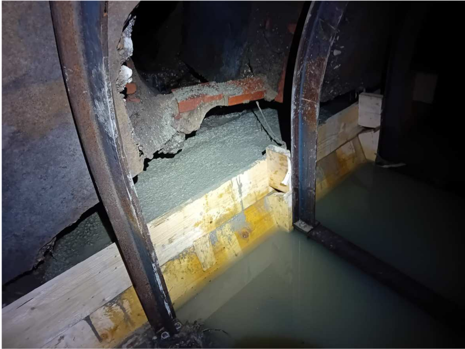
PULIZIA E RIEMPIMENTO CAVITA' CON MATTONI E MALTE CEMENTIZIE FIBRORINFORZATE
